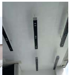
Εφαρμογή Depron® εσωτερικά στην οροφή (ταβάνι)
