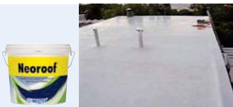
Εφαρμογή Neoroof® σε δώμα με λιμνάζοντα νερά
